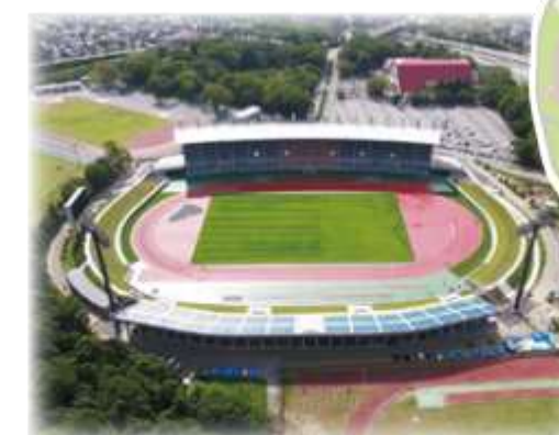
《三重交通Gスポーツの杜 伊勢 全体写真》
